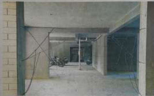
架空层内停放车辆,施工方已停止施工
